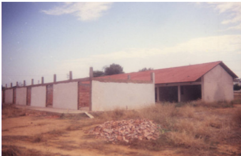
Foto 7: Estado de la construcción de la escuela (marzo1999).
