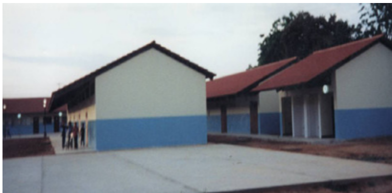
Foto 9: Estado actual de la edificación de la EBNFM (julio, 2002).
